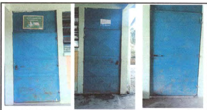
Foto 5: Lijado, cepillado y pintura de puertas
