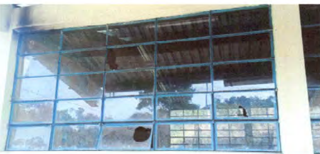
Foto 9: Sustitución de de balcon de metal
