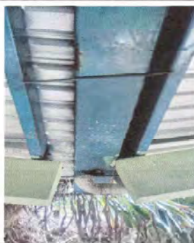
Foto 11: Sustitución de de 20ML. canal de metal
