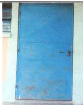
Foto 7: Lijado, cepillado y pintura de puertas
