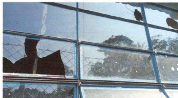
Foto 8: Sustitución de de balcon de metal de 2.81 metros de ancho por 1.28 de alto
