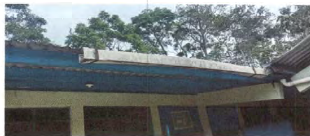
Foto 12: Sustitución de de canal de metal
