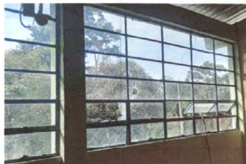
Foto 10: Sustitución de de balcon de metal
