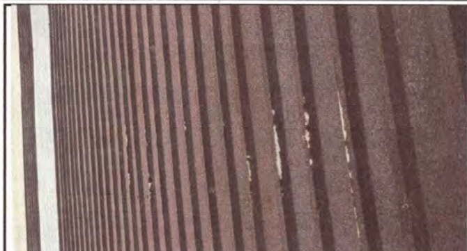
Foto 2: Sustrucción de Lamina por lamina troquelada Aluzinc.
