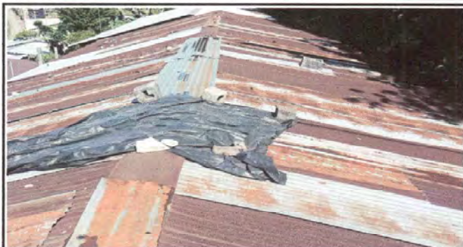
Foto 1: Sustrucción de Lamina por lamina troquelada Aluzinc. 339 M2
