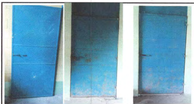
Foto 4: Lijado, cepillado y pintura de puertas
